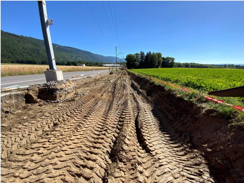
Abbildung 3-1: geotechnische Untersuchung ergab «gute» Tragfähigkeit
