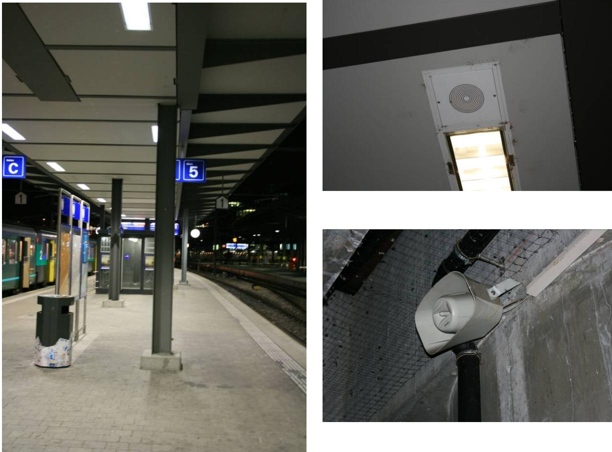
Abbildung 8.8: Bahnsteig außerhalb der Bahnhofshalle (links) sowie Lautsprecher auf den Bahnsteigen (oben) bzw. unter der Passerelle
