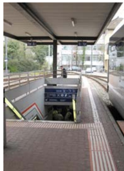
Abb. 6. Uneinheitliche Gestaltung der visuell-taktilen Sicherheitslinie, hier mit roter Farbunterlegung
