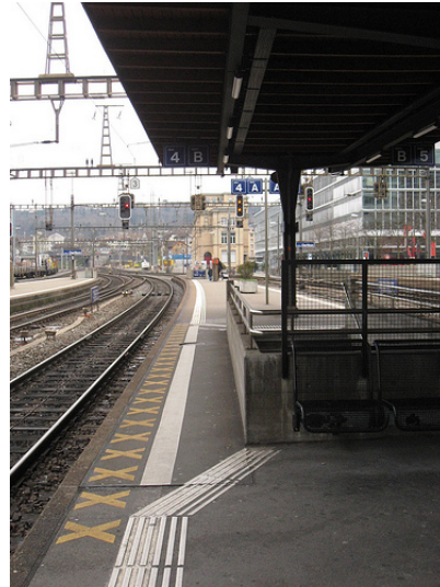
Abb. 10. Gelbe Kreuze auf dem Perronboden, die den Gefahrenbereich entlang der Treppen bzw. Rampen markieren
