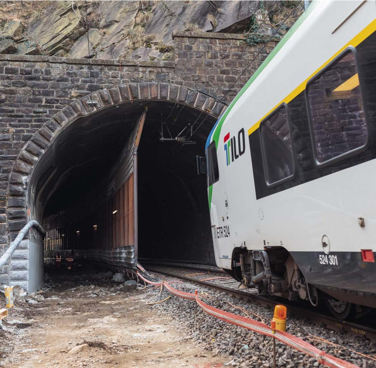
4mK: Ceneri-Bergstrecke: Profilaufweitung Molincero-Tunnel
