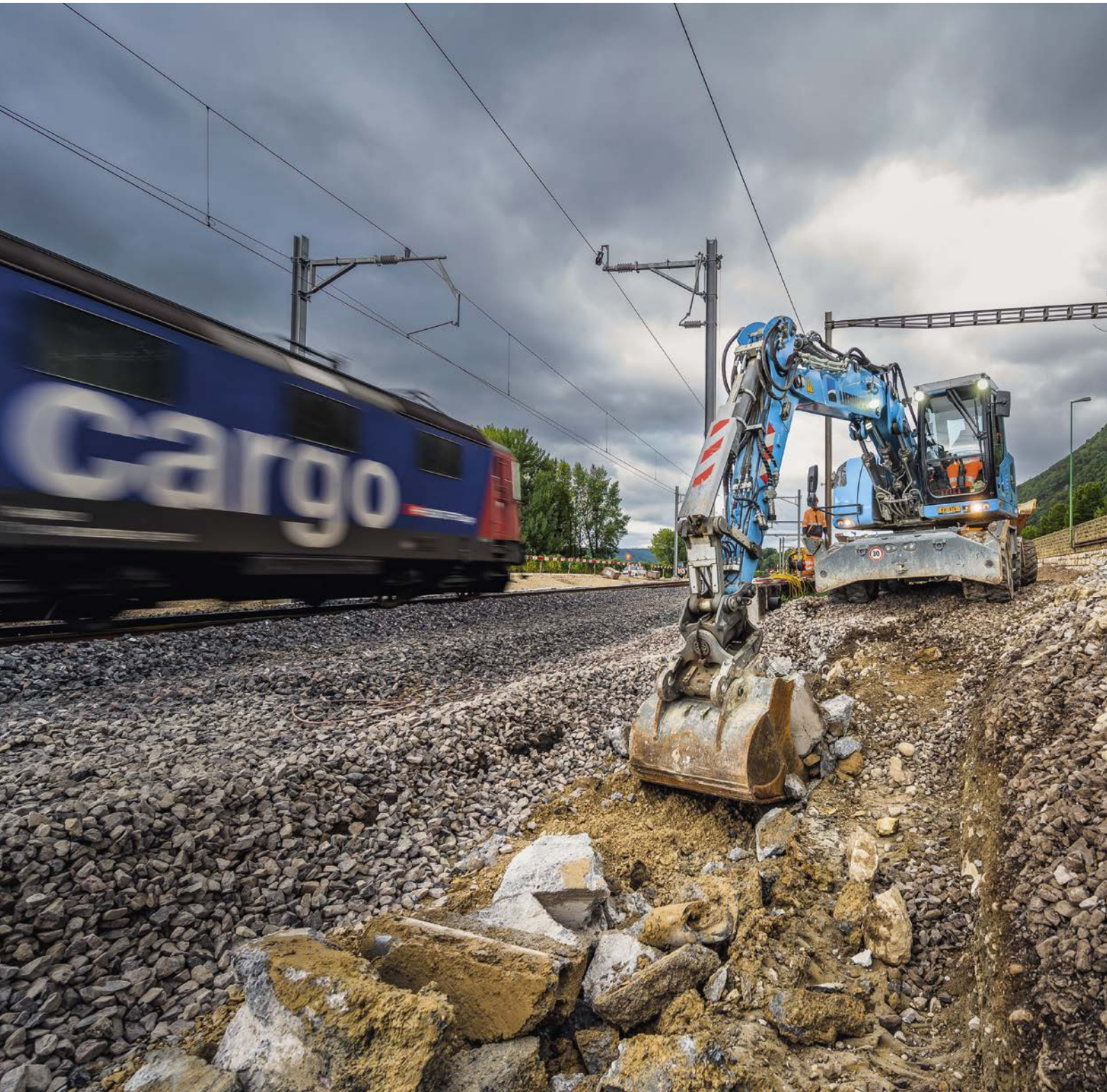
AS25: Ligerz – Twann, Neubau Doppelspurtunnel
