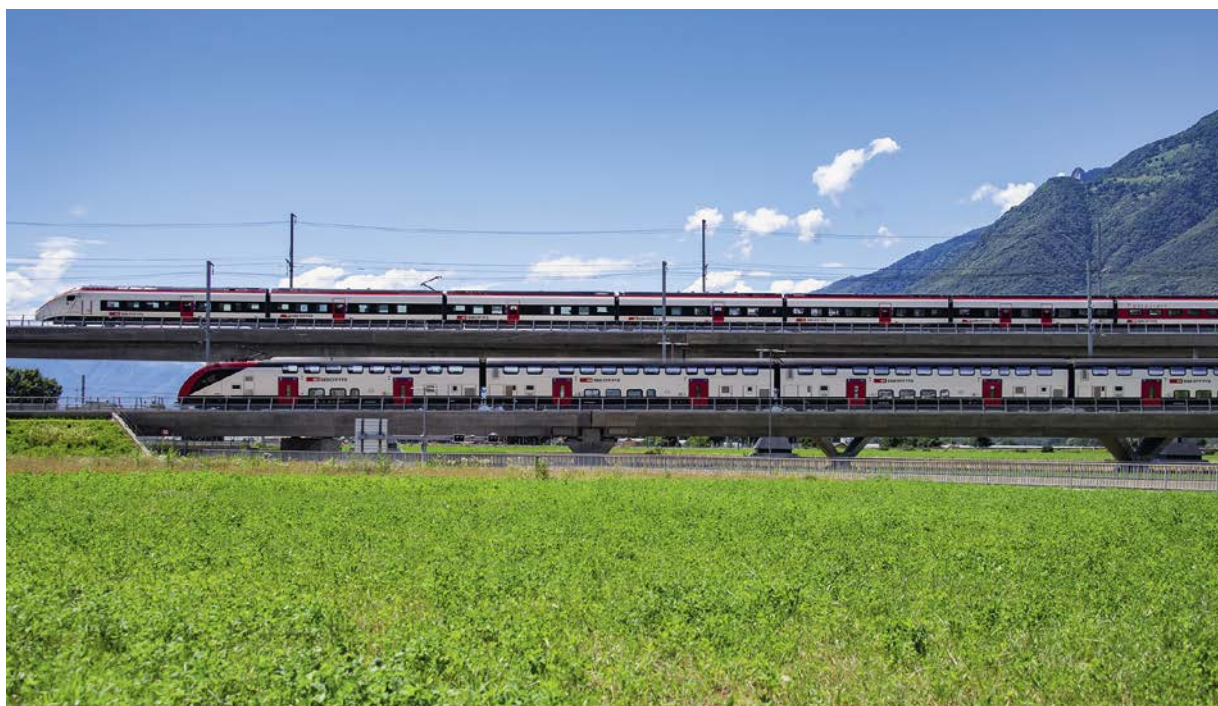
NEAT-Portal Vigana und Viadukt Camorino
