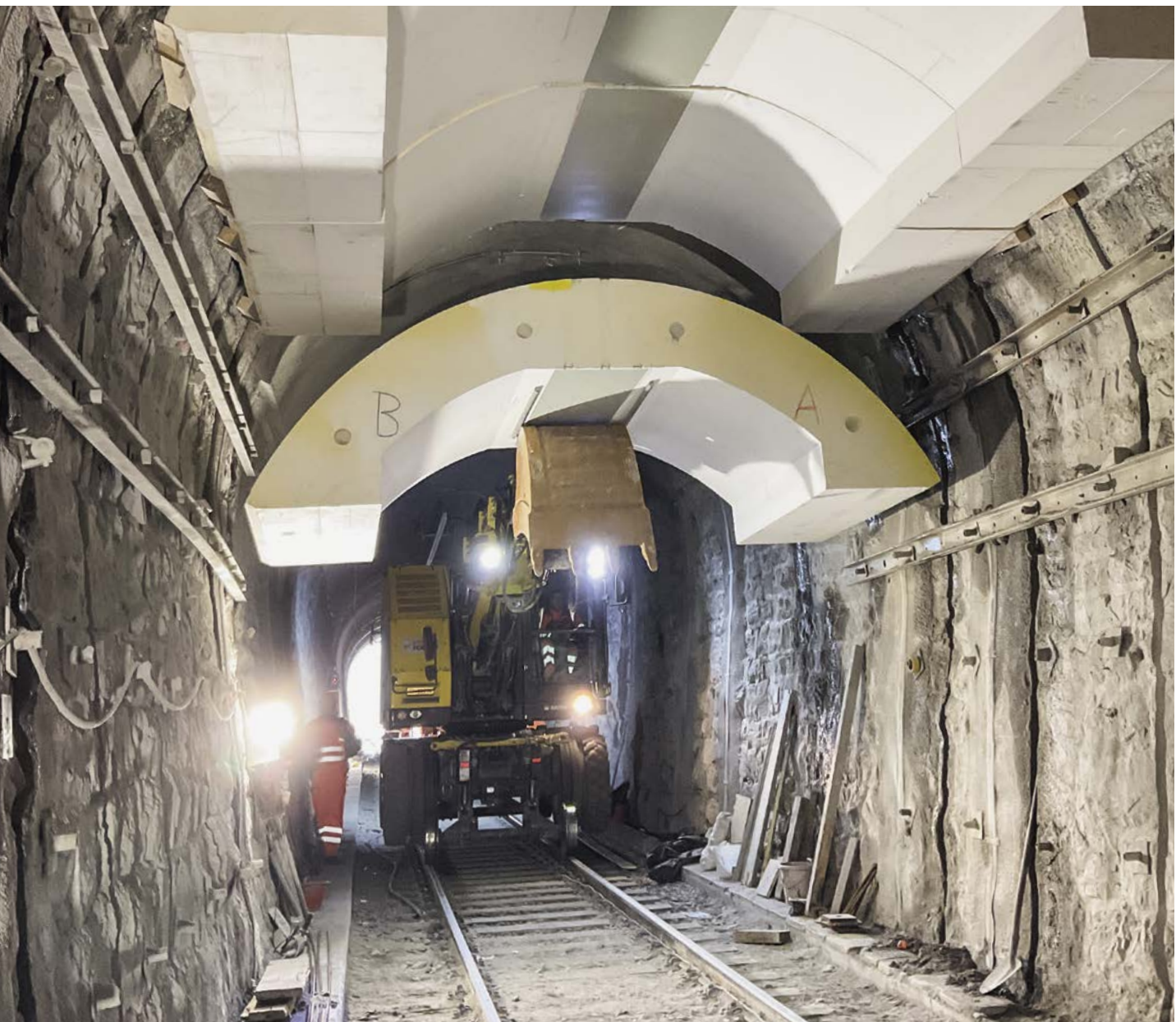
Ceneri-Bergstrecke, Profilaufweitung Tunnelabschnitt
