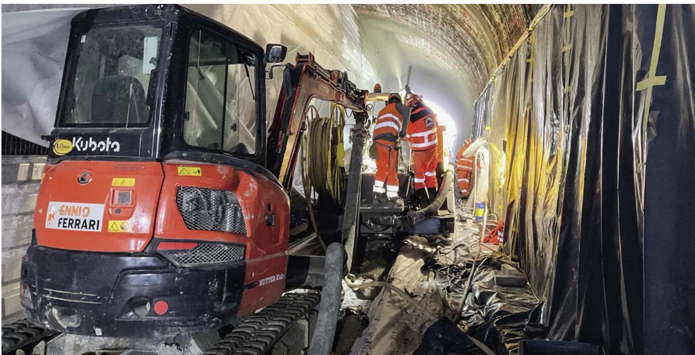
4mK: Ceneri-Bergstrecke, Profilaufweitung Tunnelabschnitt
