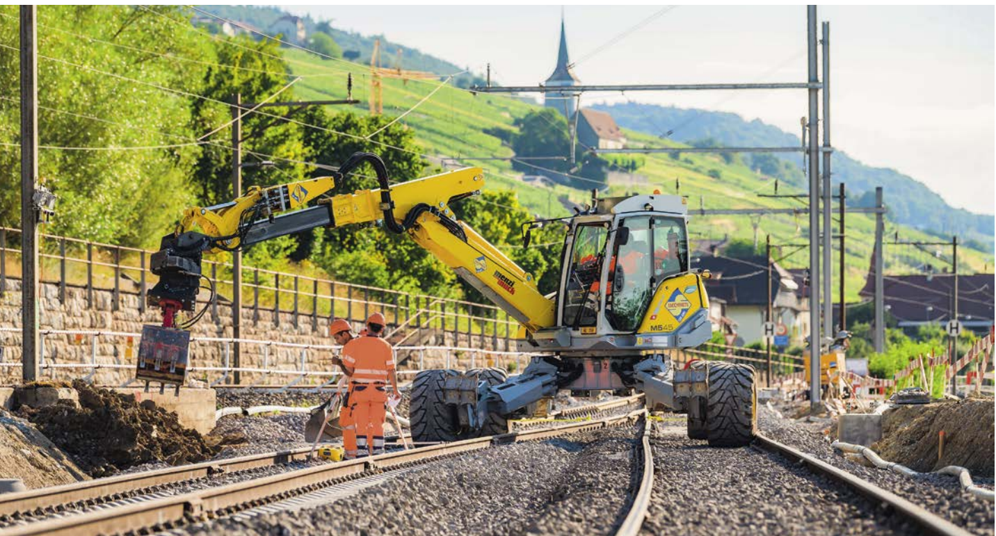
AS25: Ligerz–Twann, Neubau Doppelspurtunnel
