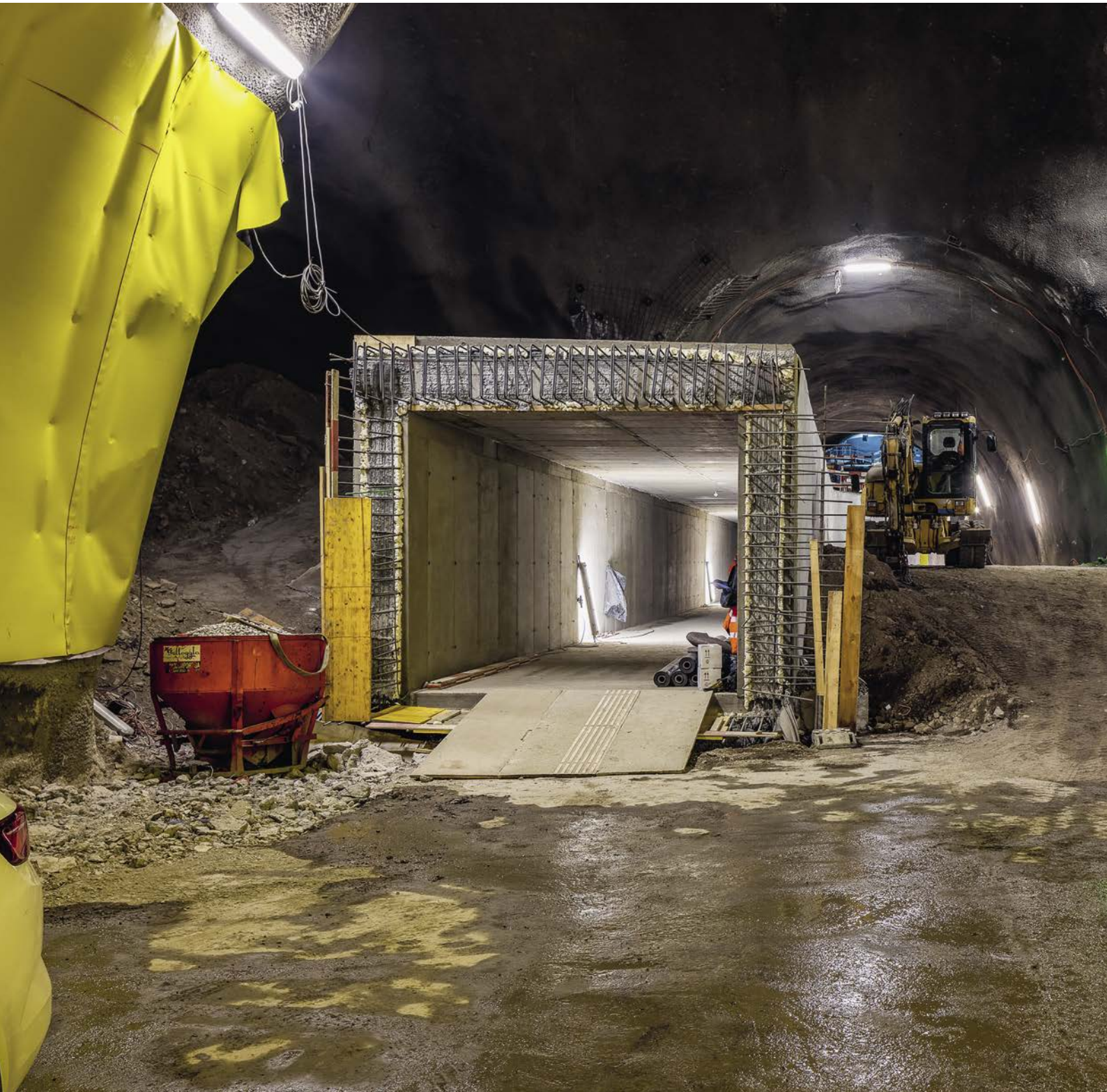
NEAT: Zugangsstollen Sigirino zu Fahrrohren CBT
