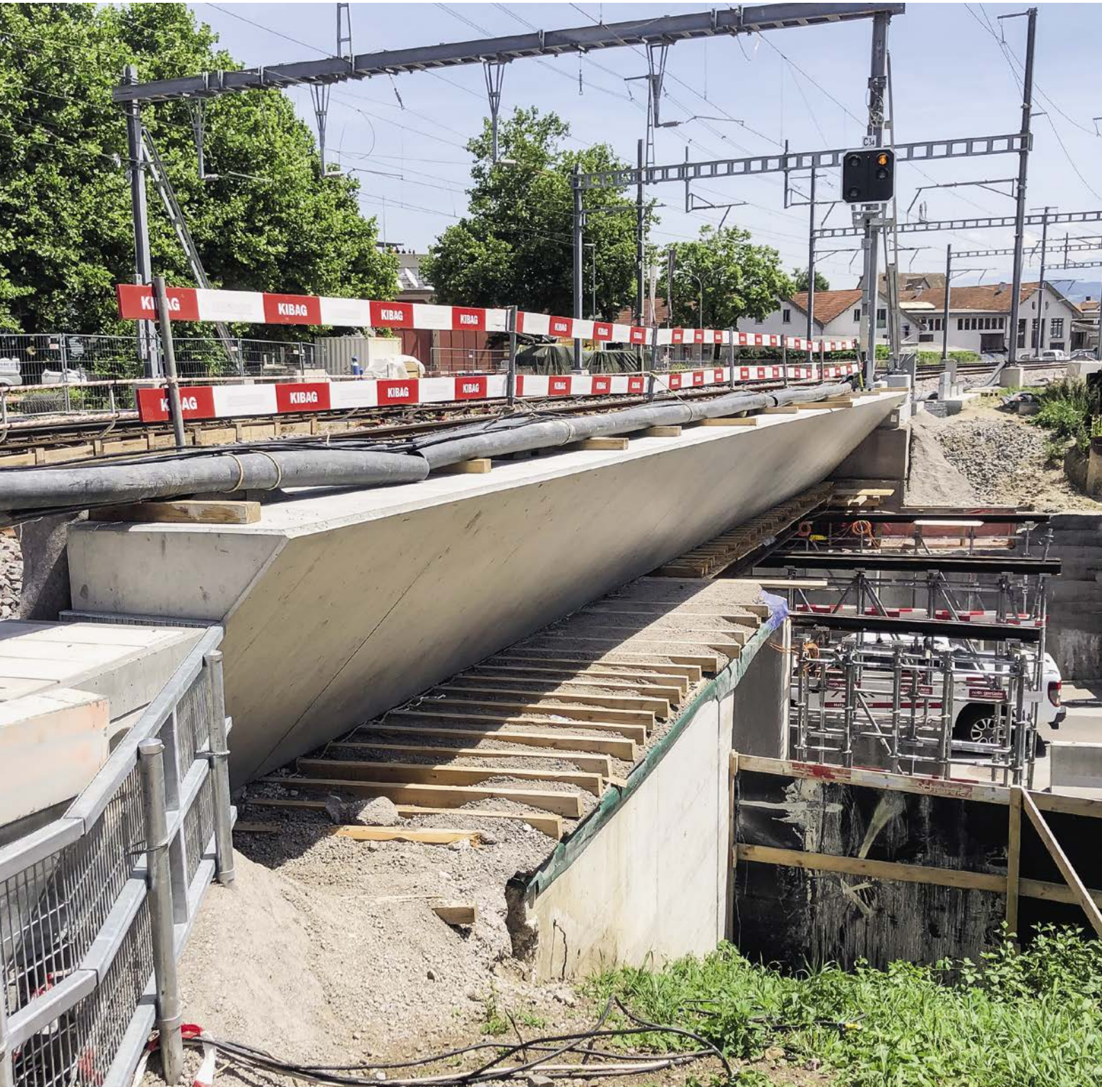
ZEB: Wil, Leistungssteigerung Bahnhof
